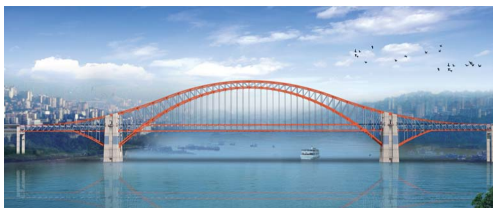
Ocelový priehradový oblúkový most Chaotianmen cez rieku Jang-c`-ťiang, s rozpätím 552 m, v meste Čchung-Čching (Chongqing), Čína (r. 2008)
